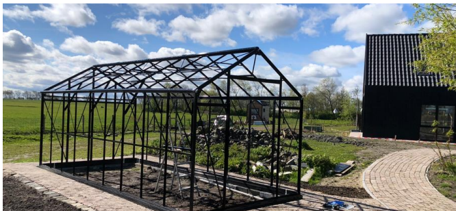
De nieuwe tuinkas in aanbouw
